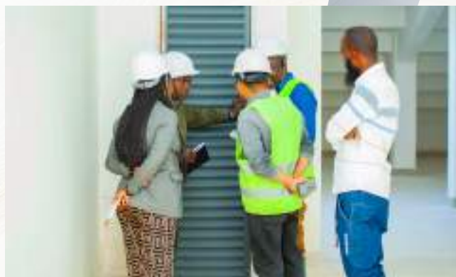
Ndugu Iman Mwalumbwe Mkurugenzi wa TEHAMA Chuo Kikuu Cha Sayansi na Teknolojia Mbeya (wapili Kushoto) akitoa maoni kwa mkandarasi kuhusu miundombinu ya TEHAMA
